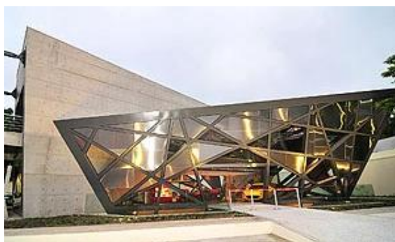
Figura 29. Edifício da loja Ferrari e Maserati. Fonte: Acervo pessoal da autora
